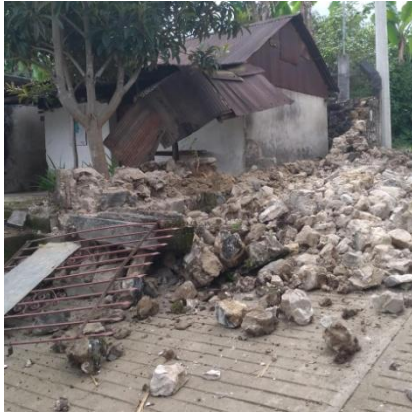
Figura 8. Derrumbe de muro de roca en Santa Cruz Ozolotepec, Oaxaca.
