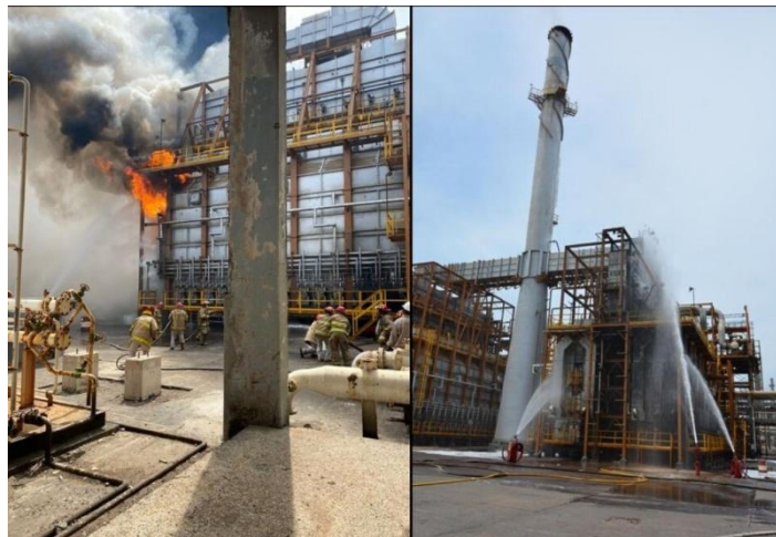
Figura 11. La refinera "Antonio Dovalí Jaime", en Salina Cruz, Oaxaca, registró un disparo en los turbogeneradores y en la caldera, lo que provocó un incendio. Foto tomada de @Pemex
