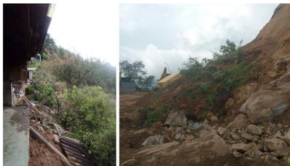
Figura 7. Caída de rocas y deslizamientos en San Sebastian Río
